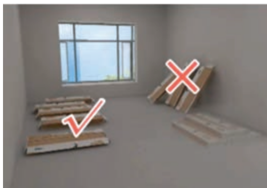
شکل ۲۶ و ۲۷- نحوه قرار دادن درست جعبه‌های لمینت
