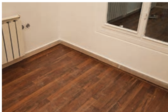
شکل ۷۷ و ۷۸ - پروفیل اسکوتیا و استفاده از آن برای اتصال کف پوش لمینت به قرنیز سنگی دیوار
