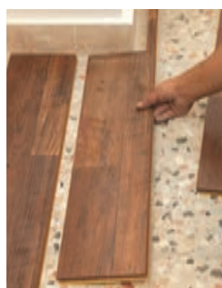
شکل ۹۰ و ۹۱ - قفل کردن قطعات لمینت به یکدیگر
