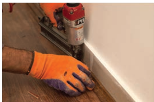
شکل ۷۹ و ۸۰ - استفاده از دستگاه میخ زن برای اتصال ابزار اسکوتیا به کف پوش لمینت
