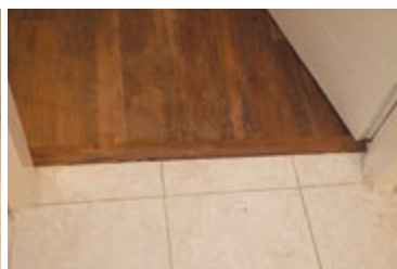
شکل ۹۲ تا ۹۴ - نصب لمینت در آستانه در
