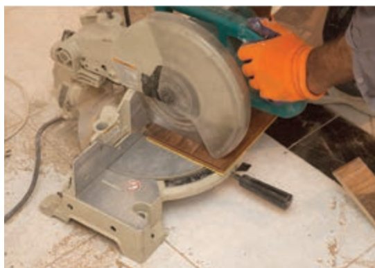
شکل ۵۶ - برش عمودی
