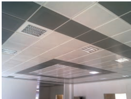
شکل ۱- اجرای سقف کاذب با مواد صداگیر
