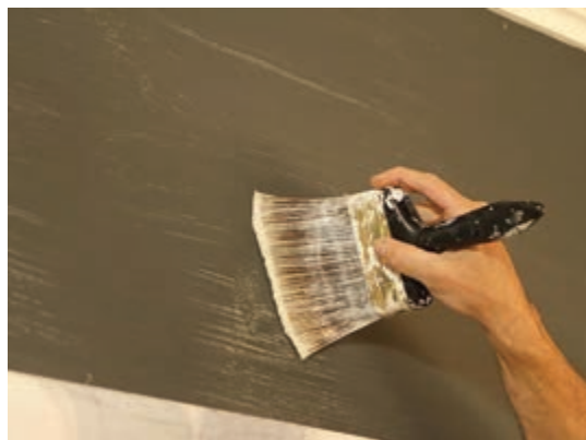
شکل ۸۴- چسب زدن دیوار
