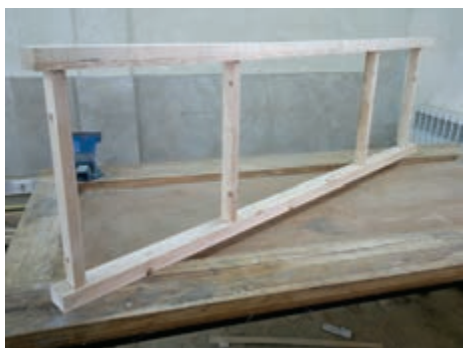
شکل ۵۲- اتصال موقت قطعات پاراوان
