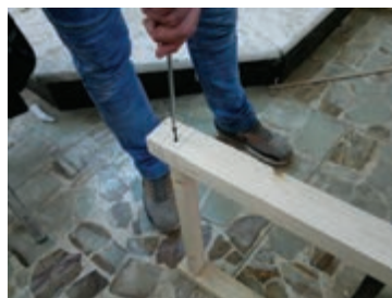
شکل ۵۶- بستن پیچ با پیچ‌گوشتی دستی
