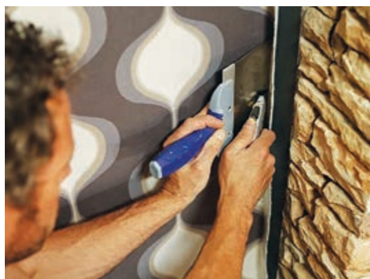
شکل ۸۵- برش اضافه پارچه روی دیوار
