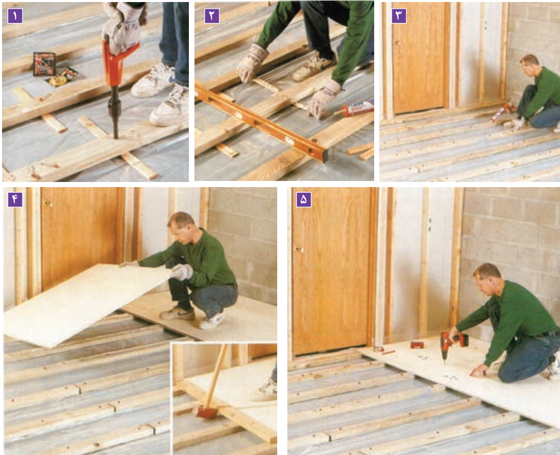
شکل ۴- مراحل نصب کف با تخته چوبی
