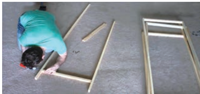
شکل ۱۹- ساخت قاب پارتیشن
