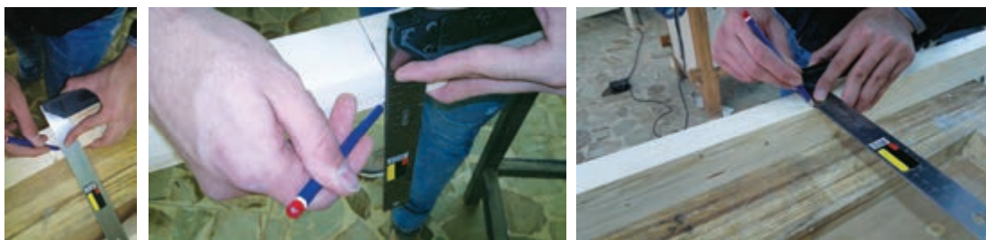
شکل ۴۵- انتقال اندازه‌ها به قطعه دوم
