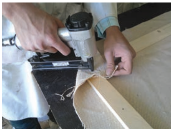
شکل ۳۲- منگنه زدن گوشه قاب
