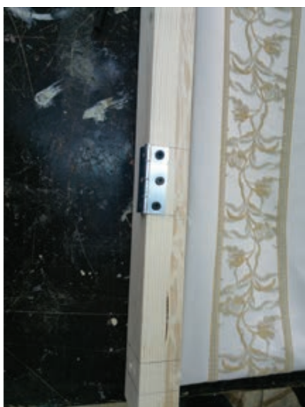
شکل ۷۲- محکم کردن برگه اول لولا با ۳ پیچ
