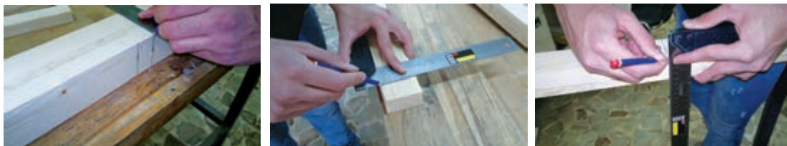
شکل ۴۴- خط‌کشی و انتقال اندازه‌ها به ضخامت چوب
