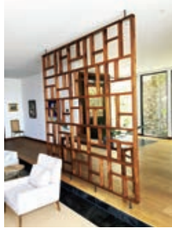
شکل ۲۳- اتصال به کف و سقف
