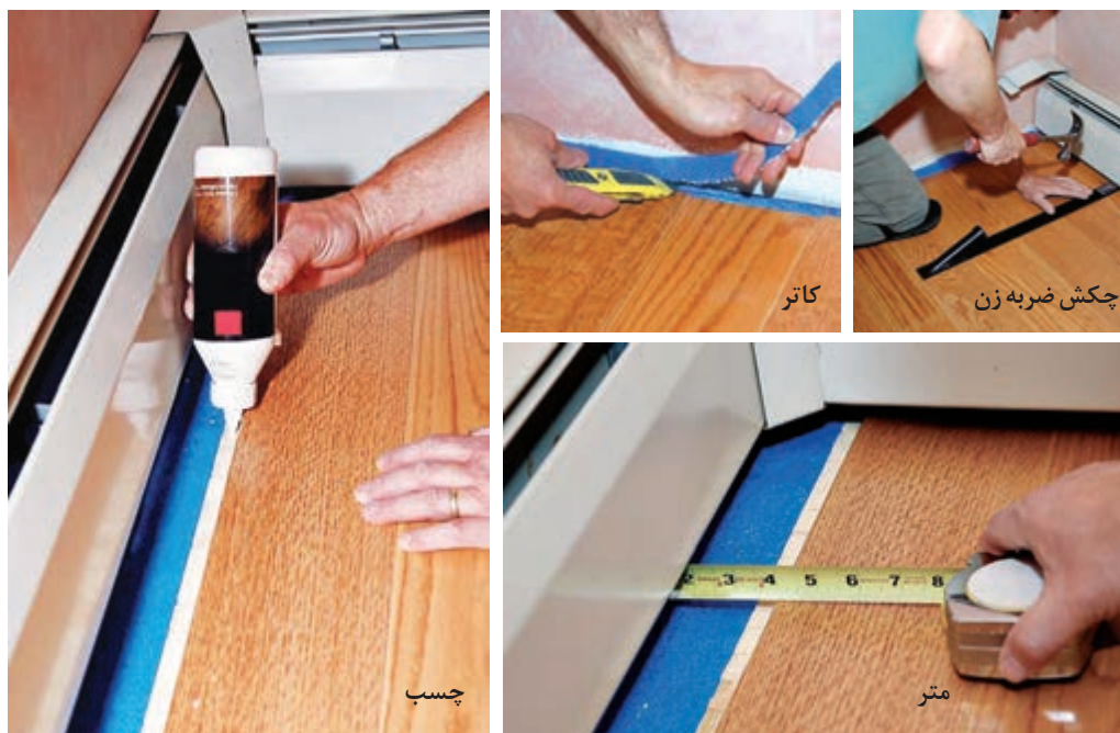
شکل ۲۵- ابزارهای مختلف مورد استفاده در نصب کف پوش لمینت
