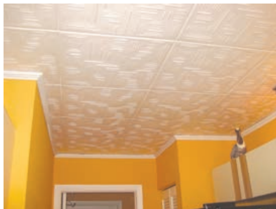
شکل ۳- اجرای سقف کاذب با فوم
