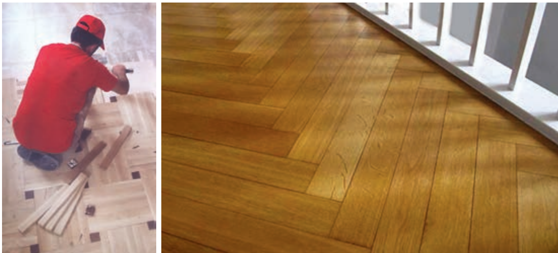
شکل ۷ و ۸- نمونه‌هایی از کف‌سازی با بلوک‌های چوبی
