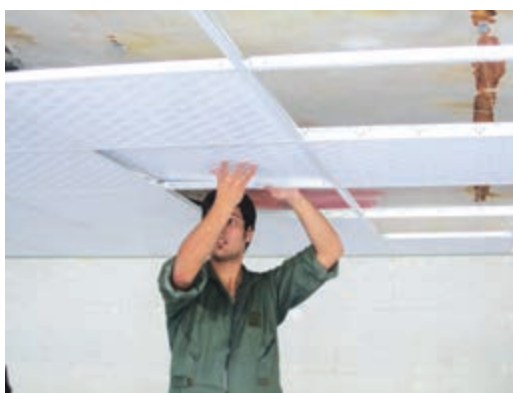
شکل ۱۷- نصب و تنظیم پنل در شبکه فلزی
