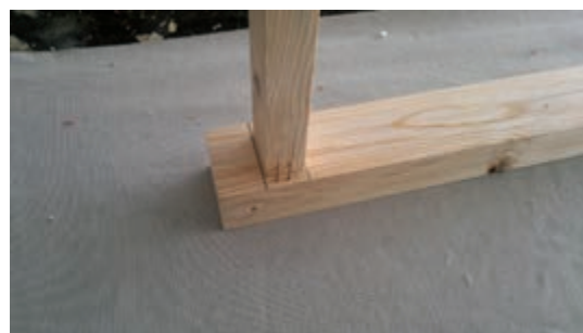
شکل ۴۹- زدن دو منگنه روی قید اول
