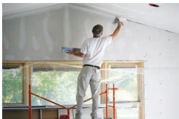
شکل ۱۸- پرداخت درز بین دیوار و سقف کاذب
