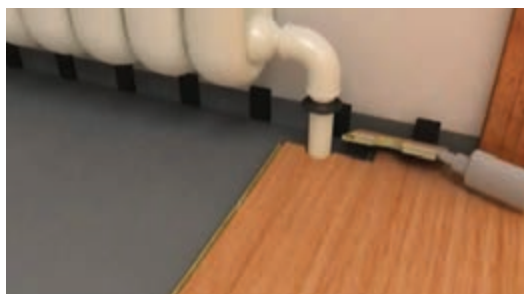
شکل های ۶۷ تا ۷۰ - نحوه نصب کف پوش لمینت در مجاورت لوله تأسیسات
