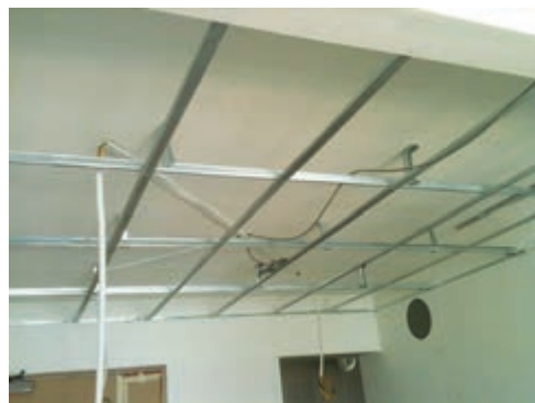
شکل ۱۶- بررسی تأسیسات و محل عبور سیم برق
