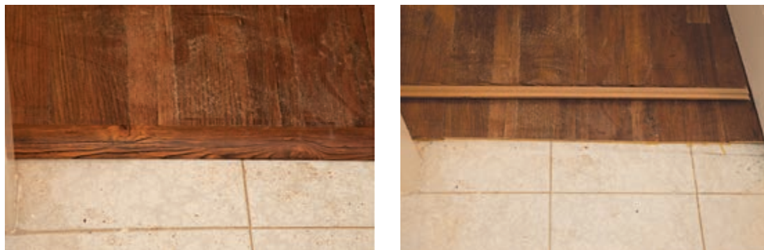
شکل ۸۲ و ۸۳ - پشت و روی پروفیل آستانه
