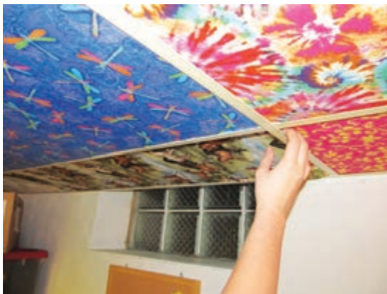
شکل ۲- سقف کاذب با پارچه نقاشی شده
