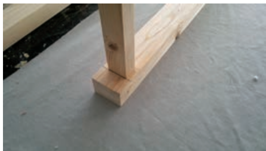
شکل ۴۷- استقرار قید افقی بر روی قید طولی
